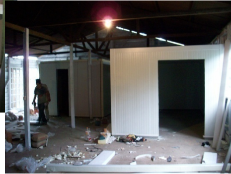
Adecuación sede de Pescadores
